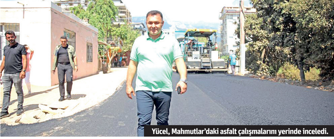
Yücel, Mahmutlar'daki asfalt çalışmalarını yerinde inceledi.
