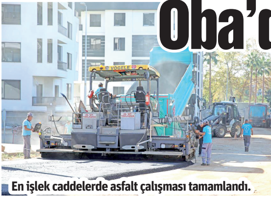
En işlek caddelerde asfalt çalışması tamamlandı.
