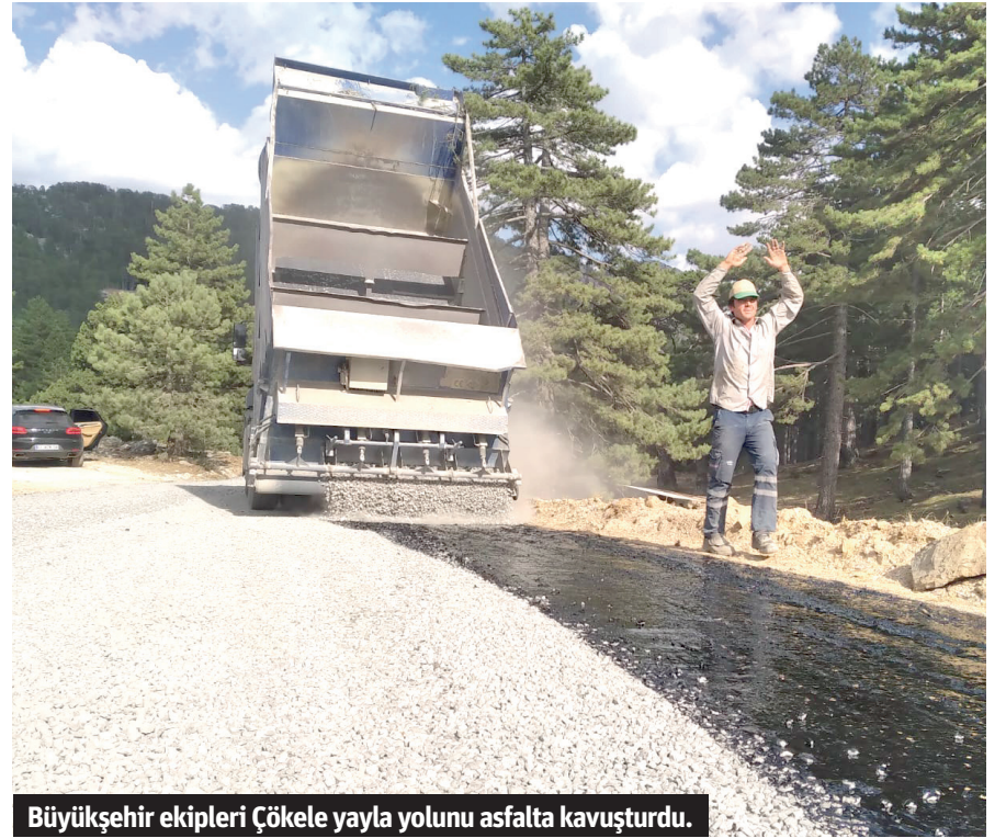
Büyükşehir ekipleri Çökele yayla yolunu asfalta kavuşturdu.
