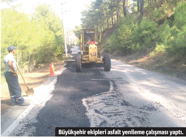
Büyükşehir ekipleri asfalt yenileme çalışması yaptı.
