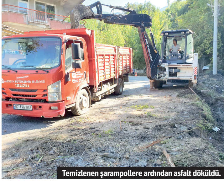
Temizlenen şarapollere ardından asfalt döküldü.
