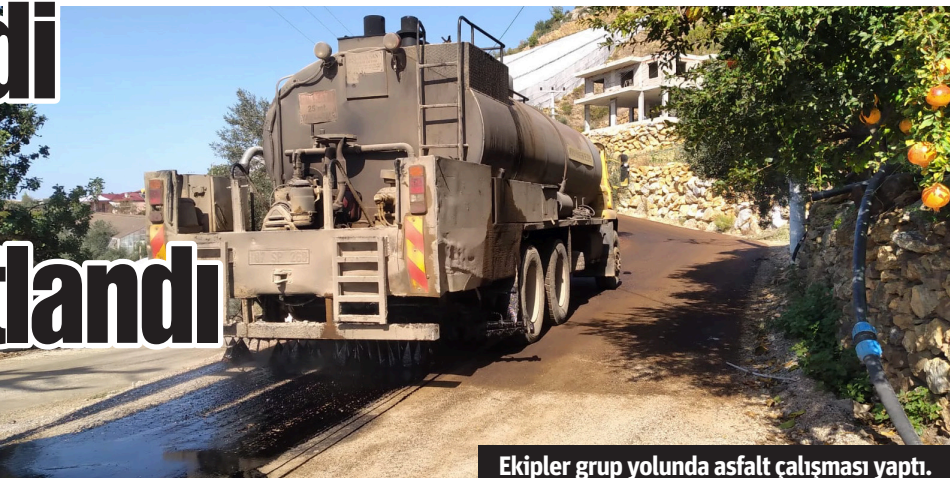
Ekipler grup yolunda asfalt çalışması yaptı.
