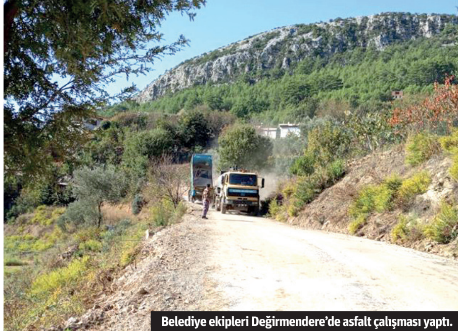
Belediye ekipleri Değirmendere'de asfalt çalışması yaptı.
