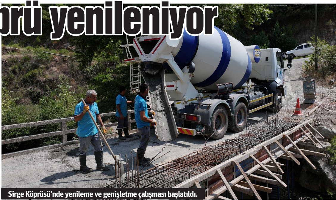
Sirge Köprüsü'nde yenileme ve genişletme çalışması başlatıldı.
