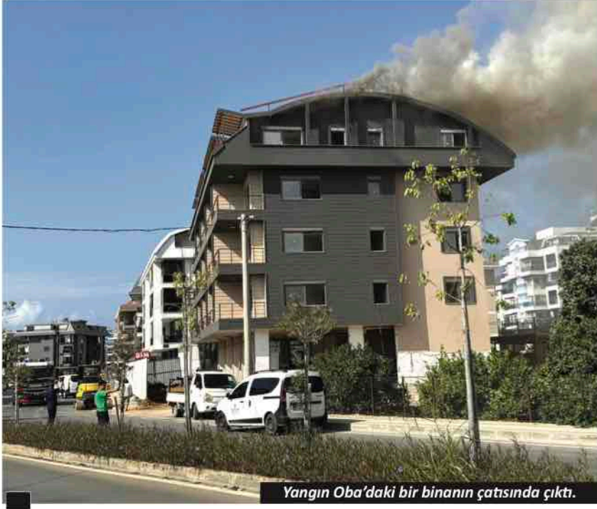
Yangın Oba'daki bir binanın çatısında çıktı.
