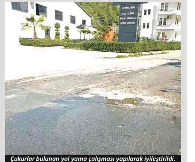
Çukurlar bulunan yol yama çalışması yapılarak iyileştirildi.
