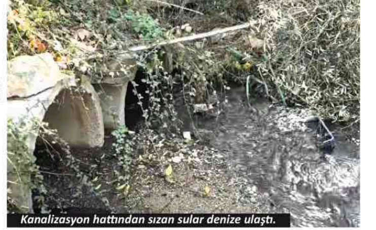
Kanalizasyon hattından sızan sular denize ulaştı.
